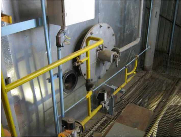
Рис. 13. Горелочное устройство блока струйного нагрева и сушки коррозионно-стойкого покрытия ленты
