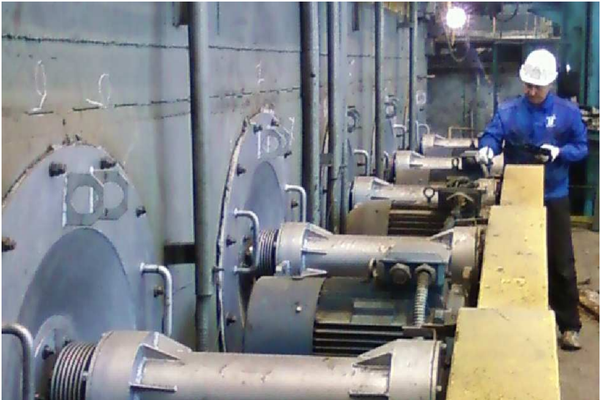
Рис. 1. Виброконтроль (вибродиагностика) печных жаропрочных вентиляторов, нагревательной печи
