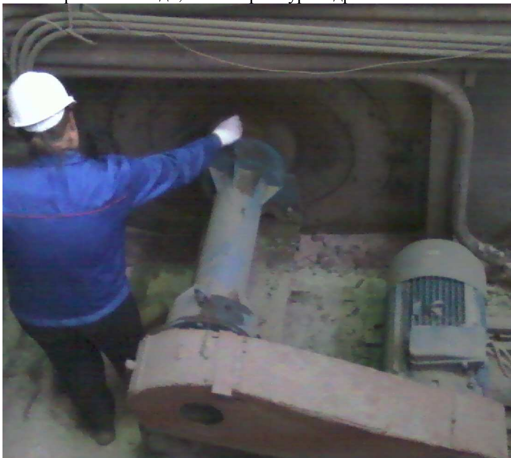
Рис. 2. Виброконтроль (вибродиагностика) печных жаропрочных вентиляторов, печи гомогенизации алюминия.
