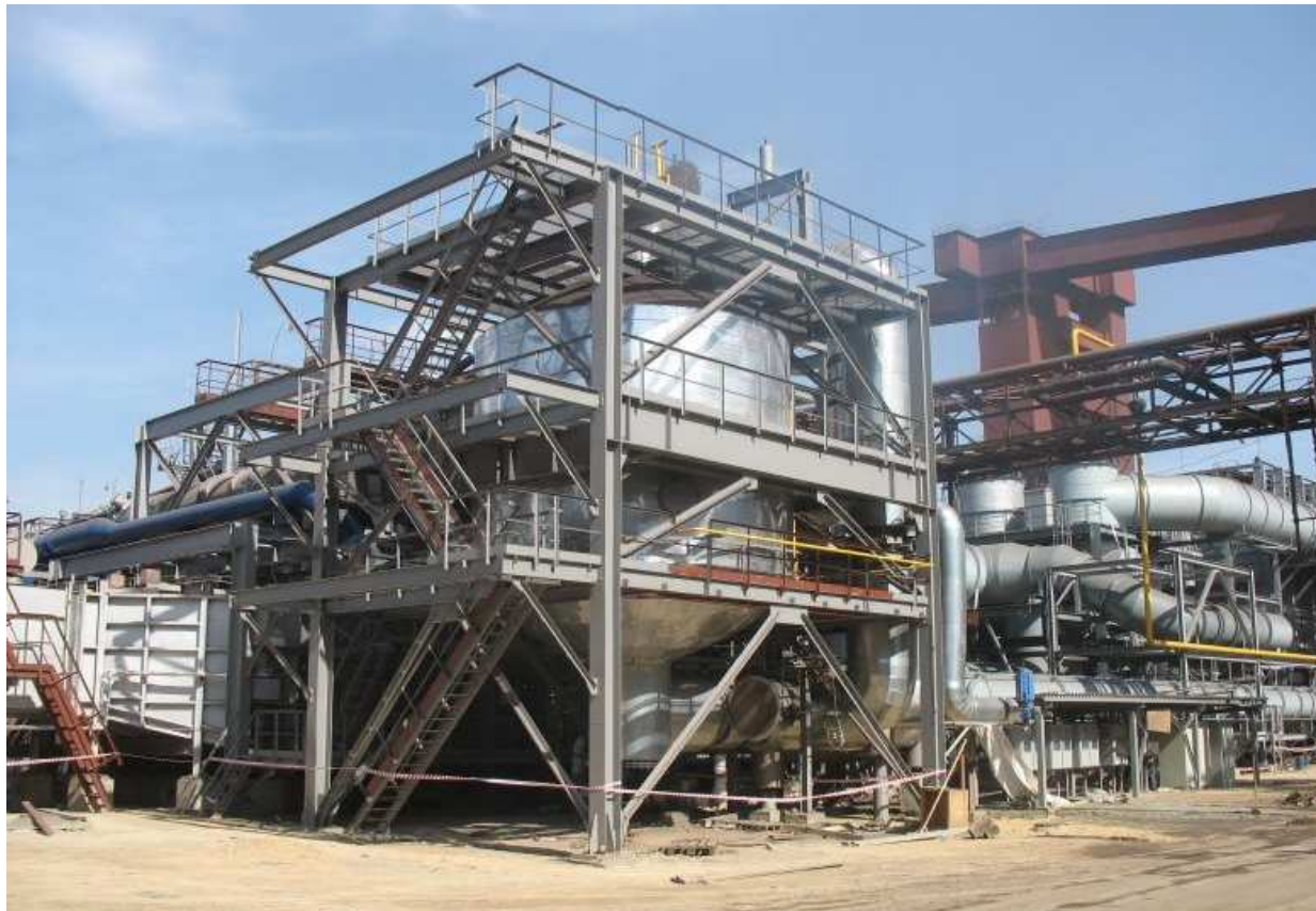
Рис. 4. Система десульфурации установки металлизации №1
